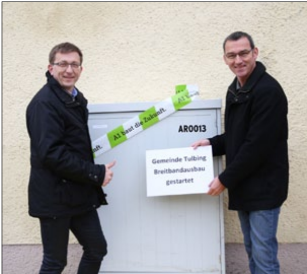
Franz Fertl und Thomas Buder bei einem neuen ARU Breitbandverteiler
